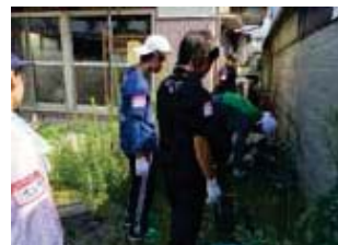
秋津地区でのブロック撤去作業
