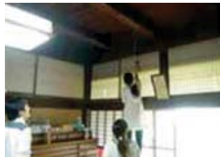
古民家の構造調査
