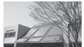
太陽光発電施設(パネル)の設置
