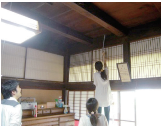
古民家の構造調査
