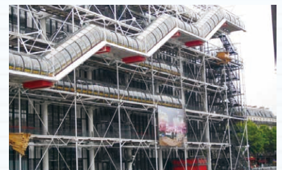
ボンビドーセンター(パリ)…これは建築中ではない。完成した美術館。創造性・多様性に寛容なヨーロッパならではのデザイン。2014年パリ調査時に筆者撮影。
